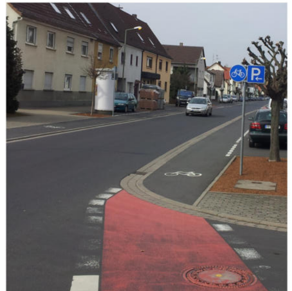
Abbildung 1: Bordsteinabsenkung Fahrbahn - Radweg, Frankfurt am Main
