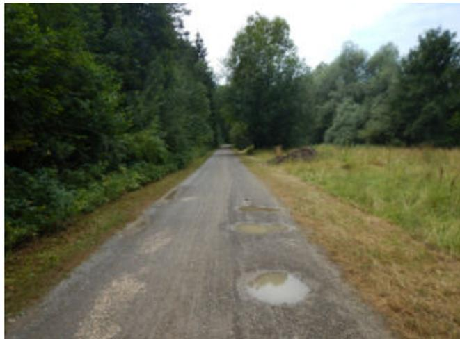
Abb. 1: Negativbeispiel: Verdichtete wassergebundene Decke mit Pfützenbildung und schlechter Wasserdurchlässigkeit
