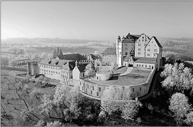
Visualisierung des geplanten Ausbaus von Schloss Kapfenburg: In der Burgmauer sieht man die schmalen Fenster des unterirdischen Gebäudes, der runde Bau auf der Wiese bei der Lorenzkapelle ist der Eingangsbereich.
