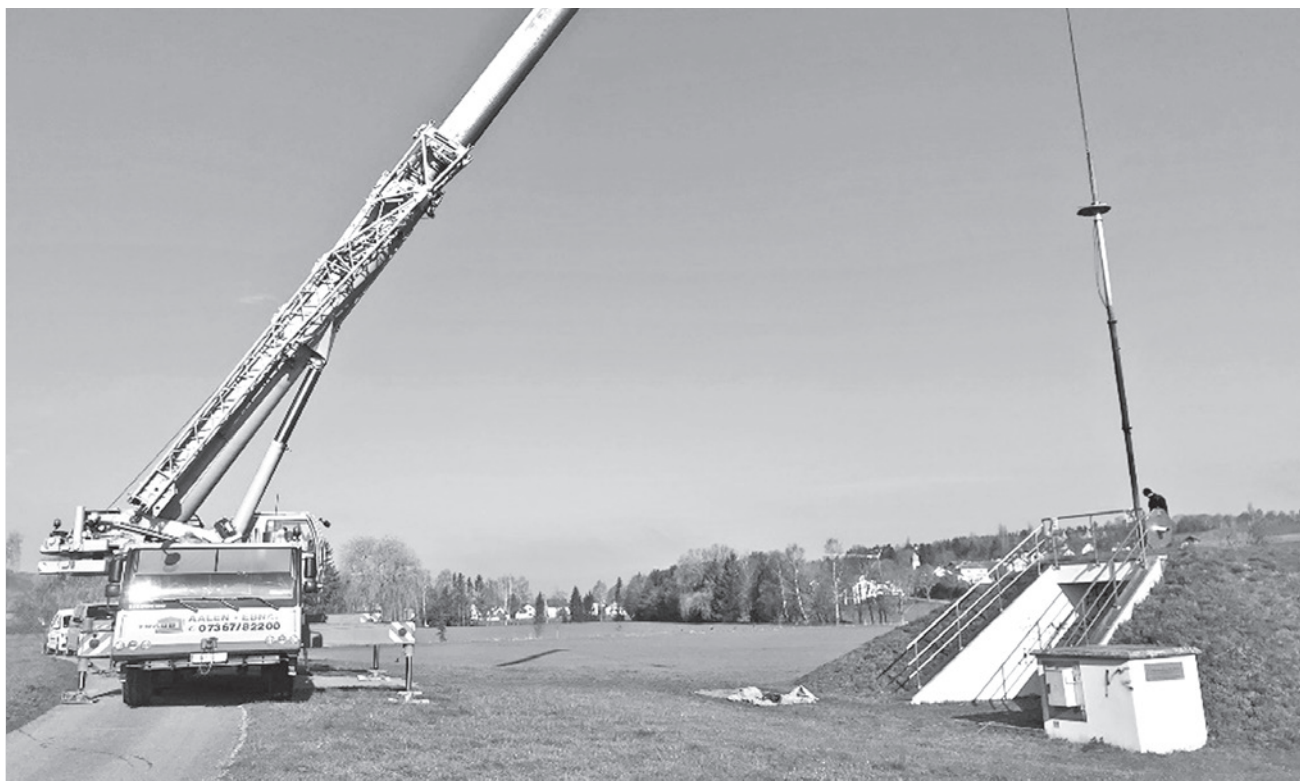
„ziehen“ der Förderpumpe mithilfe des Autokrans
